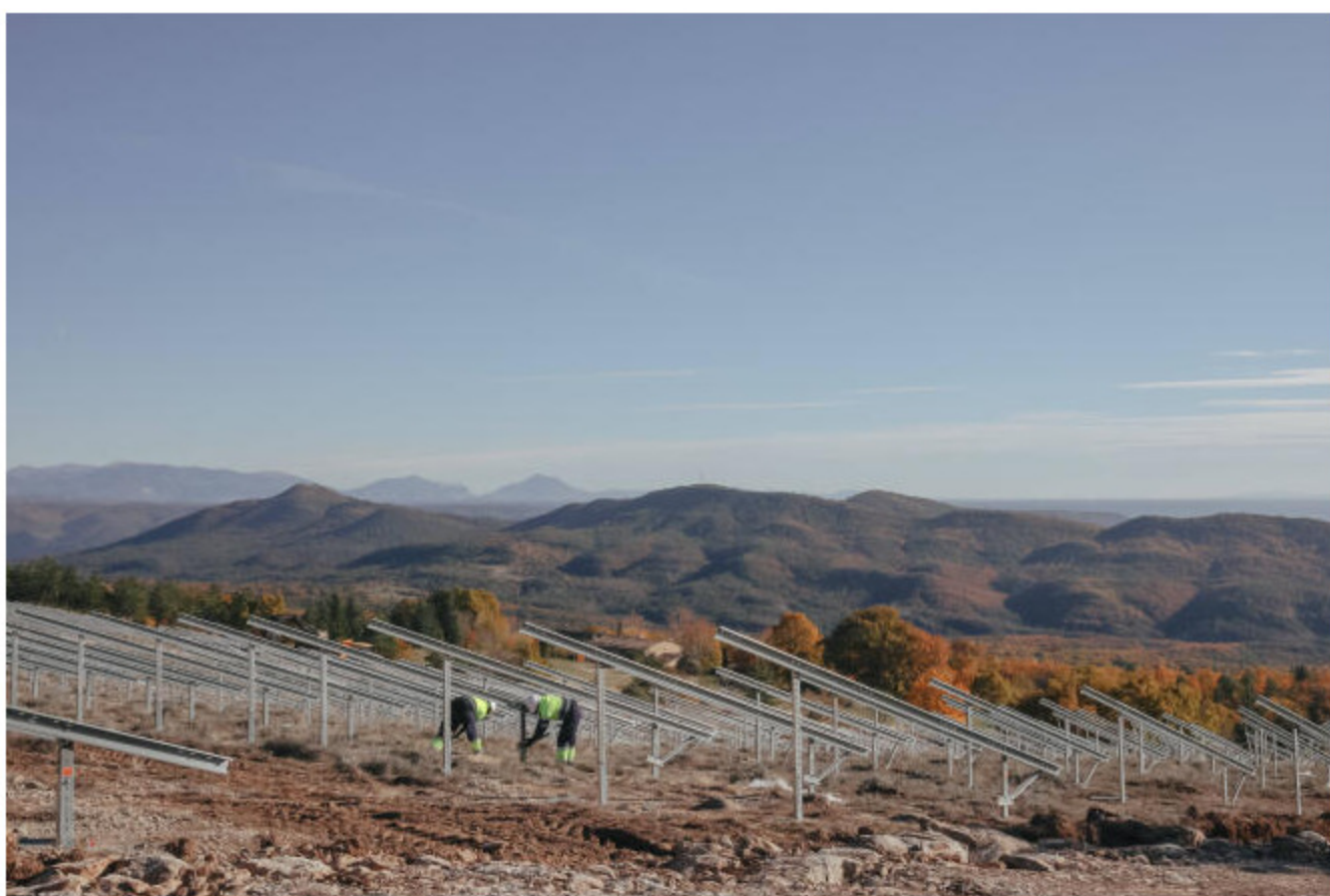
Sur le chantier de la centrale photovoltaïque de Cruis (Alpes-de-Haute-Provence), sur la montagne de Lure, le 20 novembre 2023. ANDREA MANTOVANI
