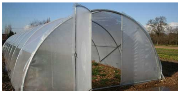
Le tunnel plastique
